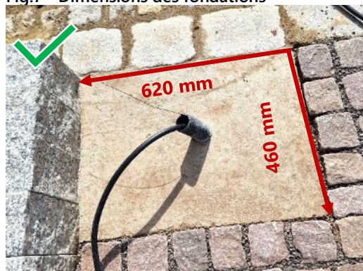
Fig.7 - Dimensions des fondations
